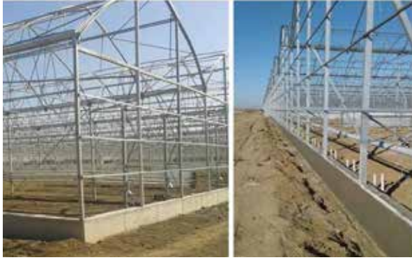
Şekil 2. Çevre Temel ve Yan Perde Betonlu
