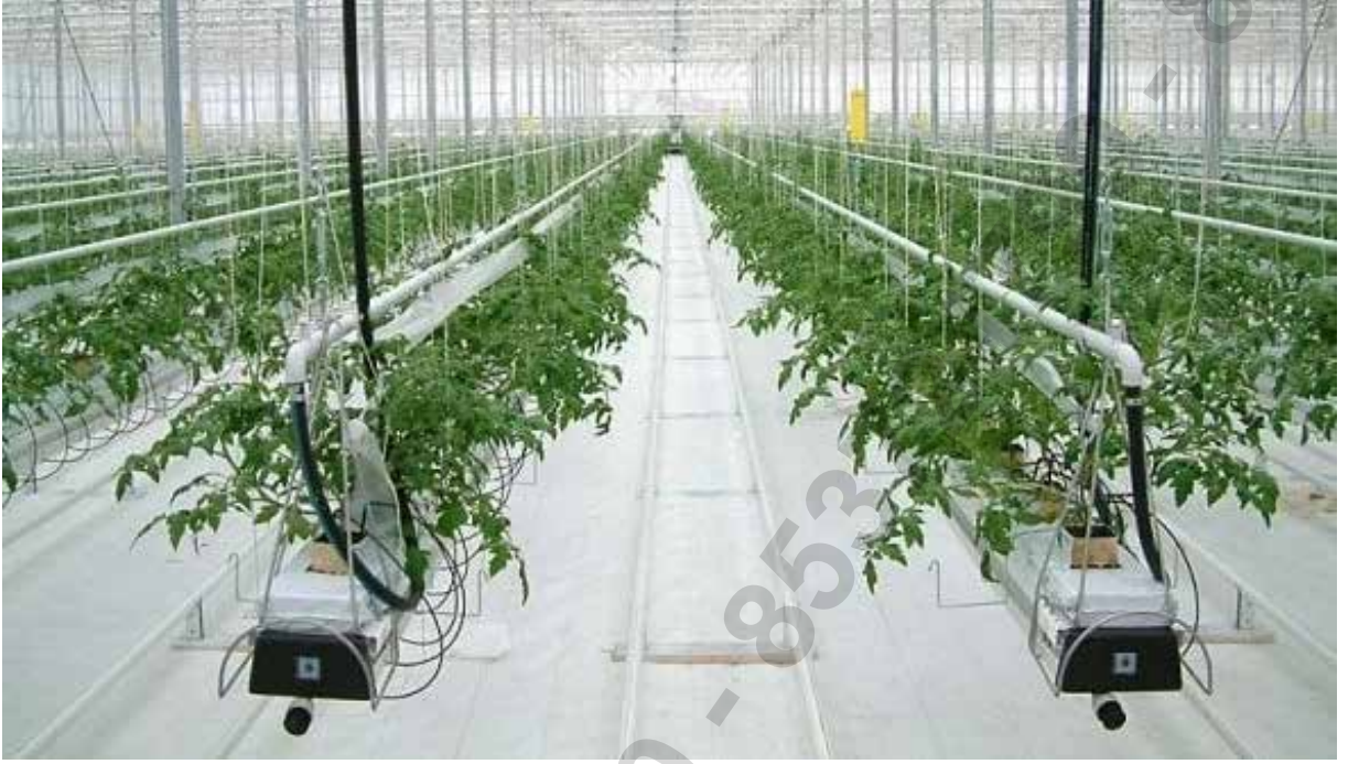
Şekil 12. Serada kullanılacak tabana yakın borulu ısıtma sistemi ve vejetasyon ısıtma
